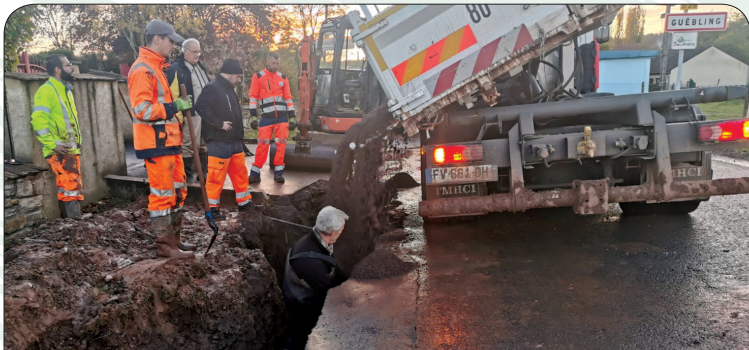
Réparation de la conduite principale à Guébling. Une scène qui se reproduit trop souvent...
