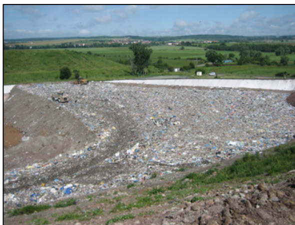
Alvéole en cours d'exploitation
