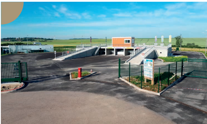
La Déchèterie de Delme
