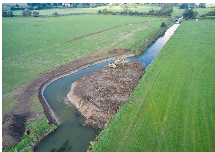
Exemple de travaux GEMAPI : cinq méandres ont été créés sur la Seille entre Burthecourt et Chambrey.
